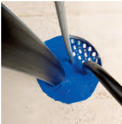
Abdichtung von mehreren Rohren und Kabeln mit DRIFIL
